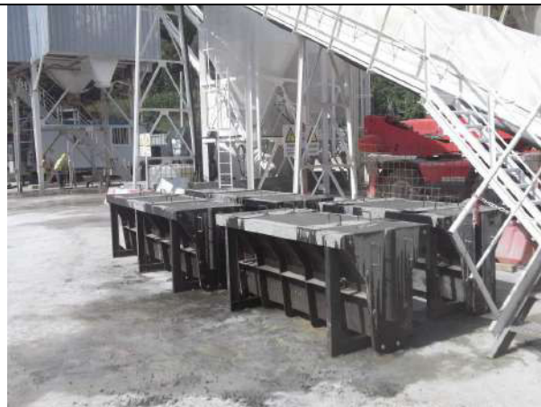
Figura 6 – Reutilização de restos de betão para fabrico de New-Jerseys no AH Daivões (01/08/2017)
