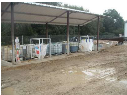
Figura 3 – Disponibilização de meios de armazenamento e triagem de resíduos no ataque intermédio (18/07/2017)
