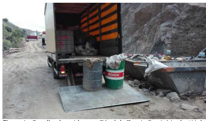
Figura 4 – Recolha de resíduos no Túnel de Desvio Provisório do AH do Alto Tâmega (14/09/2017)
